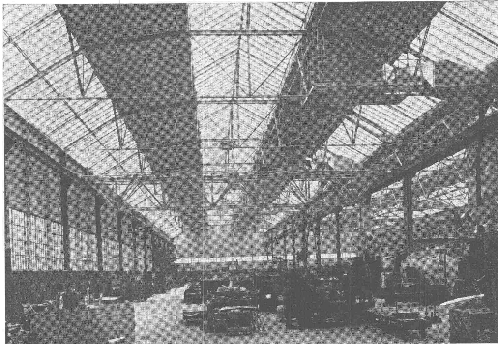
Produktionshalle, Kranerüst in Leichtmetall
