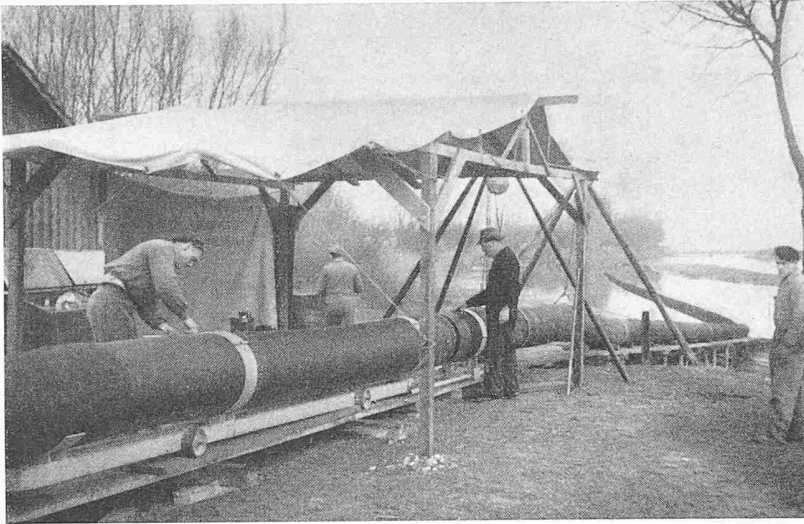
Bild 1. Die einzelnen Teilstücke werden zusammengesetzt und vulkanisiert. Die Leitung schwimmt auf dem Wasser des Alten Rheins
