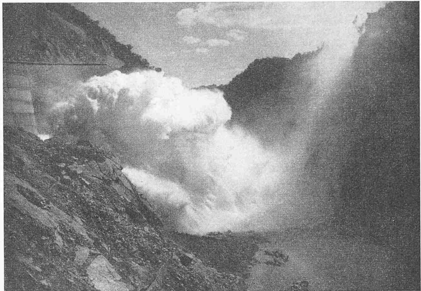
Bild 6. Probelauf zu Bild 3 mit 230 m 3 /s (Vollast 1100 m 3 /s) zwecks Prüfung der zerstäubenden Wirkung der Anordnung
