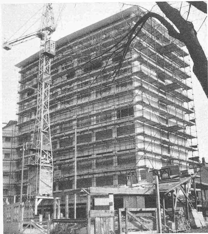
Bild 2. H-Rahmen-Fassadengerüst in Zürich
