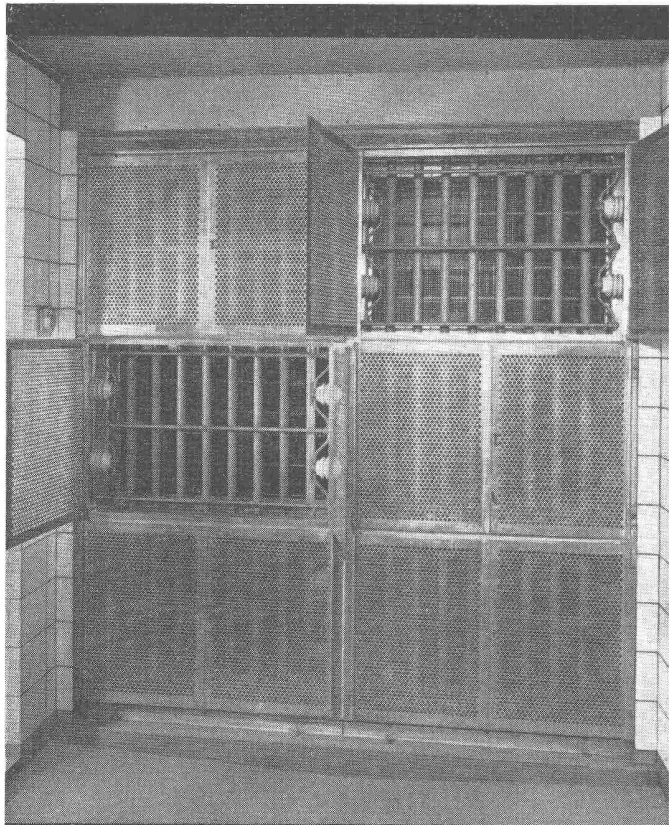
Sulzer-Elektrofilter für eine größere Luftkonditionierungsanlage, Luftleistung: 20000 m 3 /h
