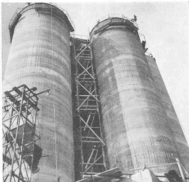
Bild 1. Sechs Silos je 30 m hoch und 7 m weit; Stahlschalung
