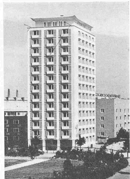
Bild 2. Hochhaus in Hamburg-Barmbeck
