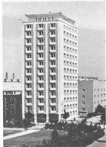
Bild 2. Hochhaus in Hamburg-Barmbeck
