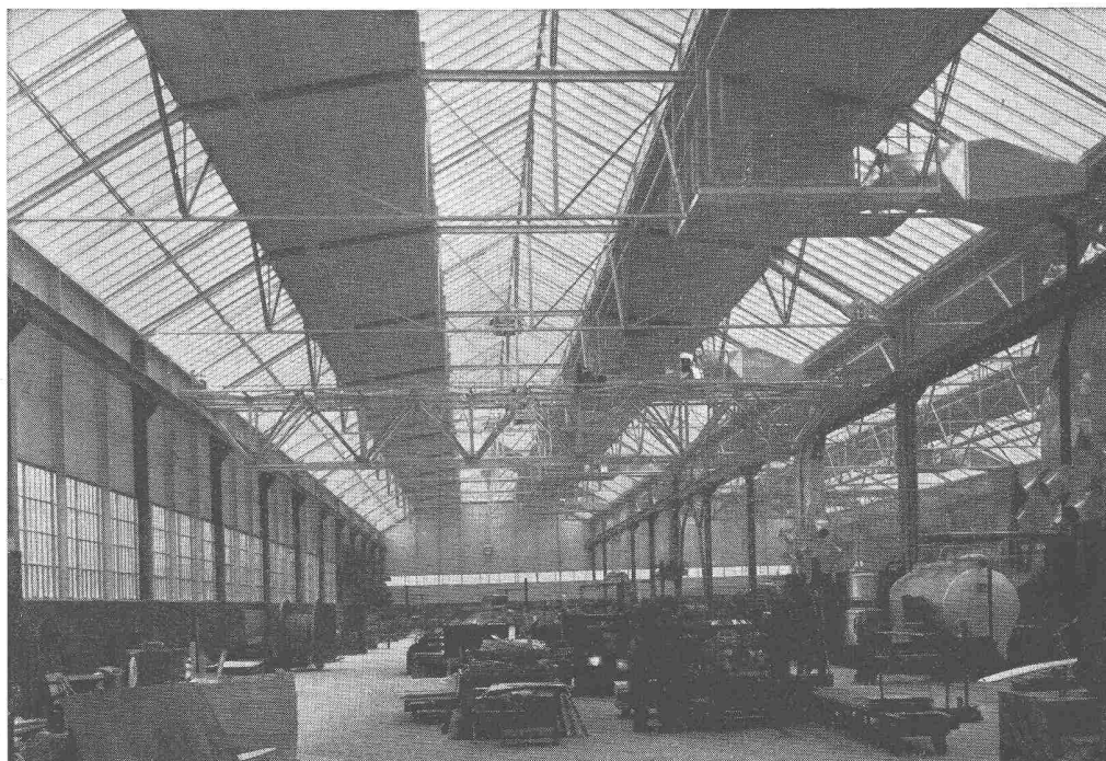
Produktionshalle, Krangerüst in Leichtmetall
