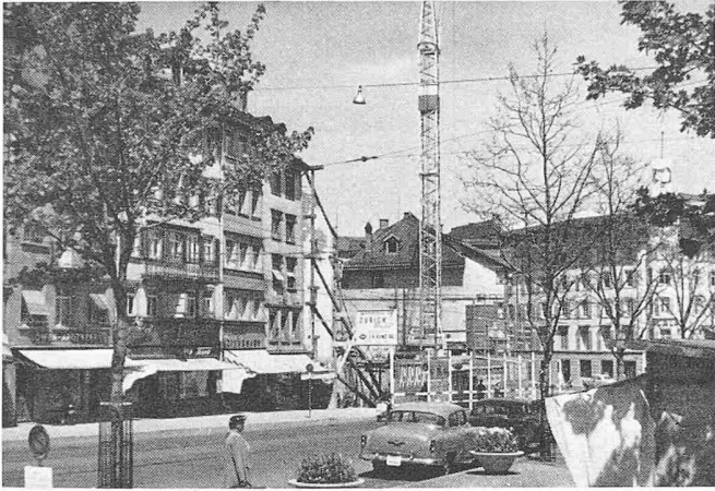
Marktplatz im Umbau
