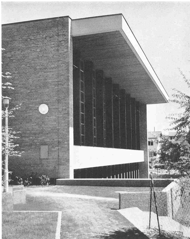
Südwestecke der Turnhalle
