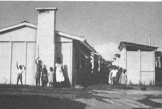
Bild 4. Stirnseite mit Nebenbau
