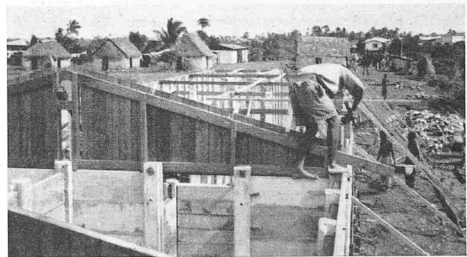
Bild 10. Befestigen der Holzbinde
