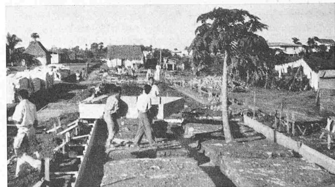
Bild 11. Vorbereitungen zum Aufstampfen der Beton-Grundplatte
