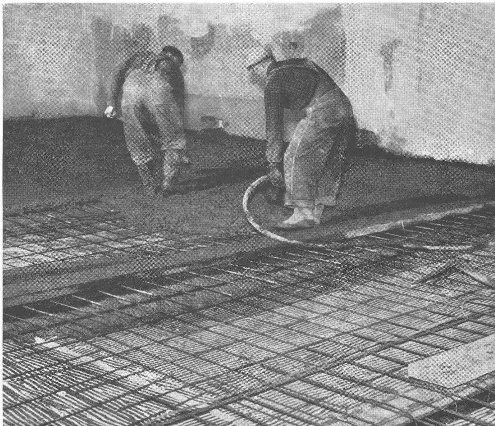
Superisol mit Putzträger, in Schalung gelegt und mit Beton vergossen (Schweden)
