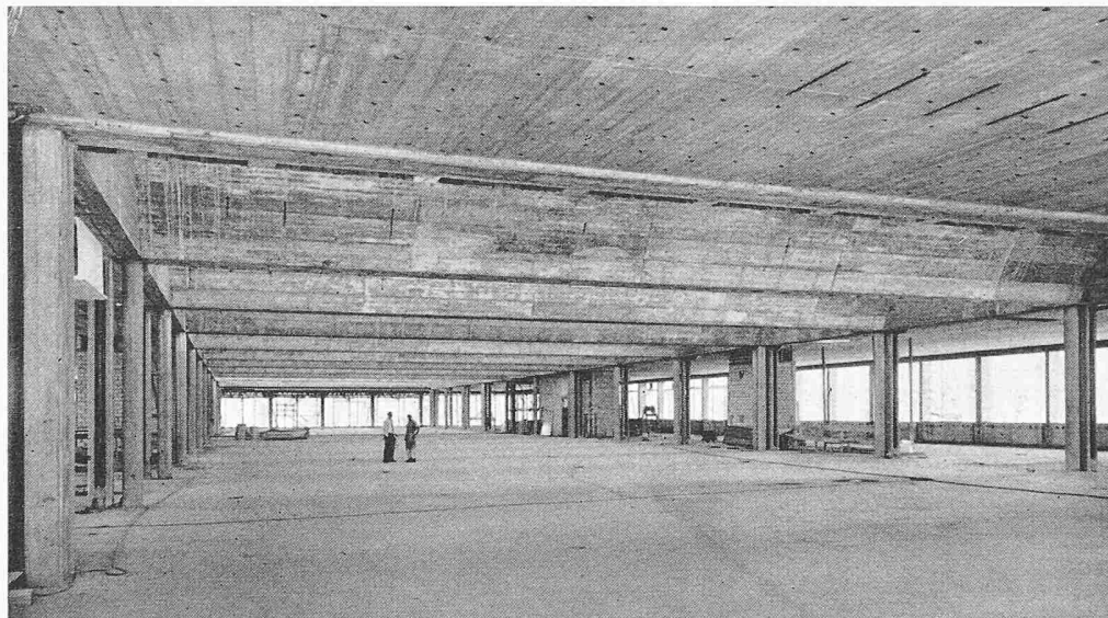
Bild 3. Innenansicht der Shedhalle (Grundfläche 2600 m 2 )
