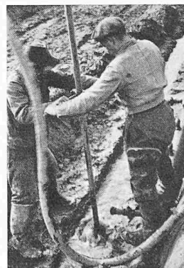
Bild 8. Ländernach-Kanal, Einspülen der Filterrohre
