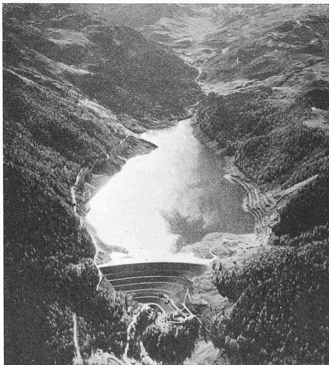
Damm und Stausee Marmorera am 19. Okt. 1954. Photo Militärflugdienst
