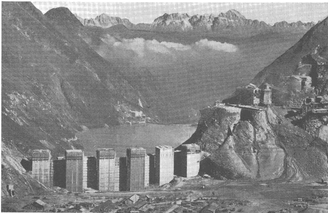
Mooserbodensperre der Tauernkraftwerke Kaprun - Salzburg, erbaut in FRIOPLAST-Beton (Im Hintergrund: Limbergsperre in PLASTIMENT-Beton)
