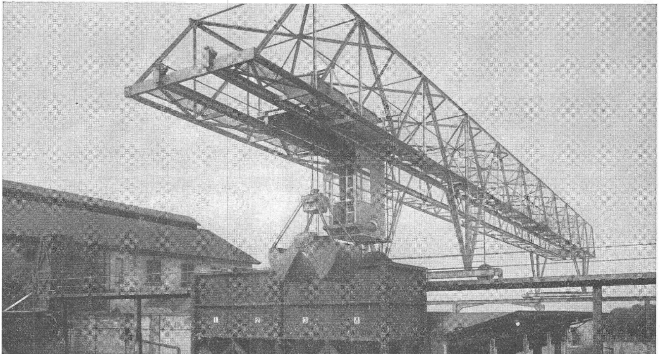
Verladebrücke in Schweisskonstruktion 2,5 t Tragkraft, 46 m Länge
