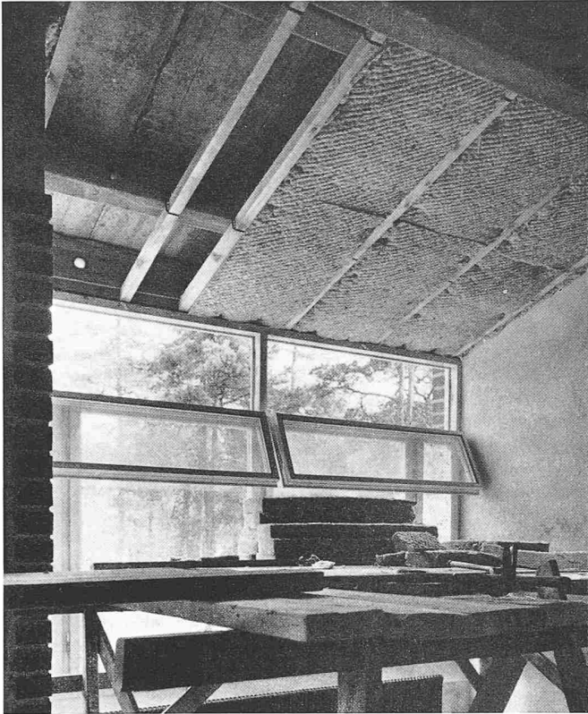
Fig. 15. Isolation sous la toiture
