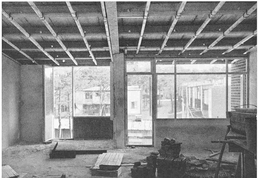
Fig. 17. A l'étage supérieur, avant la pose de la cloison
