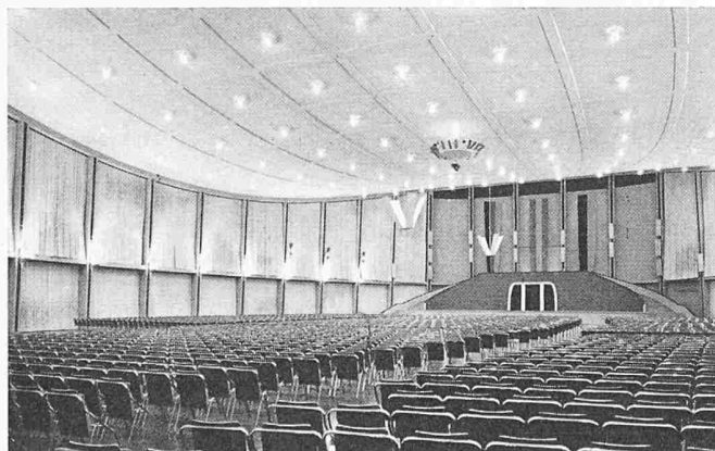
Bild 28. Schwarzwaldhalle in Karlsruhe (Deutschland), 1953. Vorspannte Hängeschale in Sattelform über einer ovalgeformten Grundfläche von 3200 \text{ m}^2 mit 73,50 m Spannweite in der Längsrichtung und 48,60 m in der Querrichtung. Durchhang in der Längsrichtung 4,50 m, in der Querrichtung 1,25 m, Dicke der Schale 5,8 cm bis 7,8 cm bei den Rippen zur Unterbringung der Spannstäbe \phi 26 des Systems Dywidag, Längsspannglieder im Abstand von 40 cm, Querspannglieder in Rippen, Abstand 5,0 m. Entwurf der Tragkonstruktion: Studienbureau Dyckerhoff & Widmann KG. (Dir. Dr. Ing. U. Finsterwalder), München. Ausführung: Arbeitsgemeinschaft Dyckerhoff & Widmann KG., Ways & Freytag AG. und Jordan, Karlsruhe
