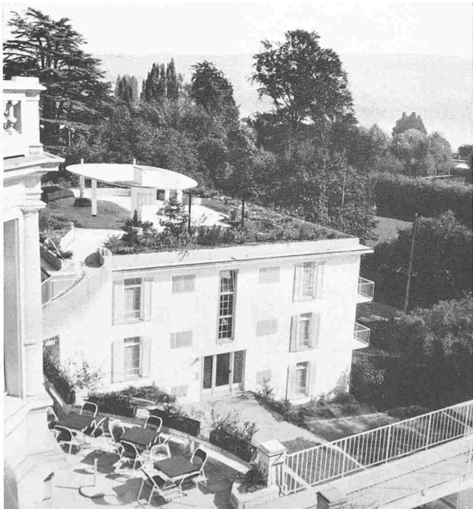
Blick von der Villa auf den Dachgarten des Hauses 2; die Verbindungsbrücken von der Terrasse der Villa zu den Dachgärten sind gut ersichtlich
