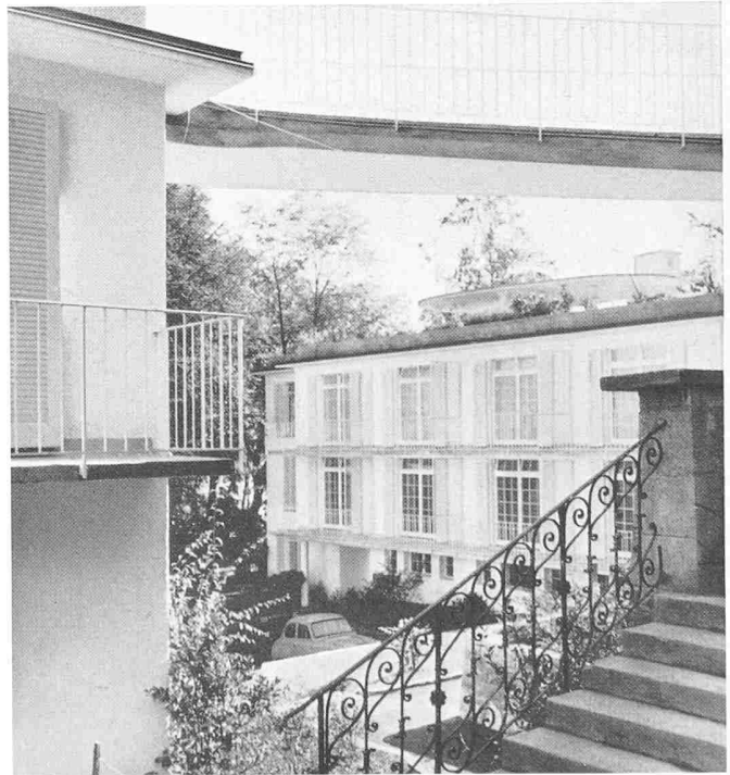
Blick in den Hof des Einganges Seestrasse; im Vordergrund der alte Treppenaufgang, oben die Verbindungsbrücke zum Dachgarten des Hauses 2
