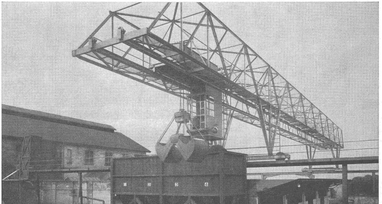
Verladebrücke in Schweisskonstruktion 2,5 t Tragkraft, 46 m Länge
