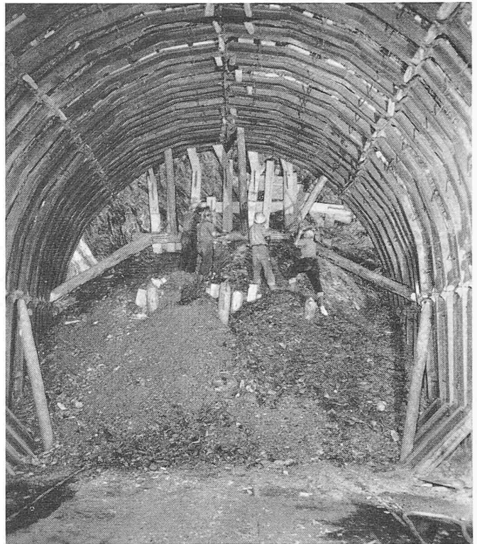
Bild 10. Vollausbuch in Mylonit; Westseite Km. 2,370
