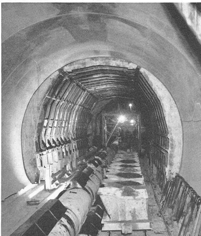
Bild 9. Betonieren im April 1951
