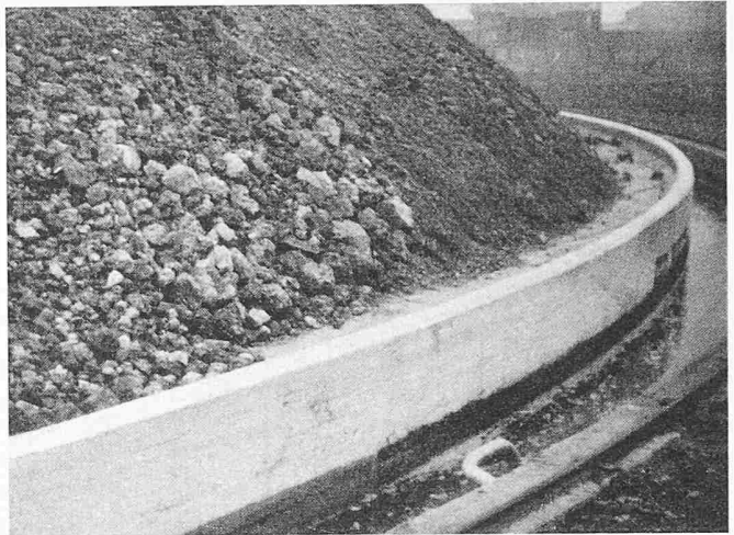
Bild 15. Grobes und feines Tropfkörpermaterial wahllos aufgeschüttet
