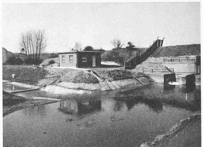
Bild 19. Kontrollstation zur Ueberprüfung der Wasserqualität
