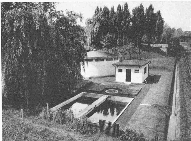
Bild 16. Landschaftspflegerisch gut gestaltete Kläranlage
