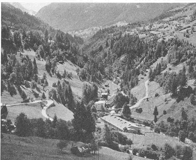
Bild 7. Maschinenhaus der Industriellen Betriebe der Gemeinde Siders in Vissoie und Entsandungsanlage des Kraftwerkes Chippis-Navisence der AIAG. Gebiet der Neuanlagen des Kraftwerkes Vissoie
