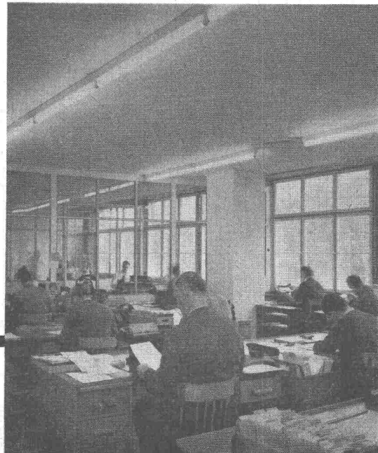
Klimaanlage in Bürogebäude
