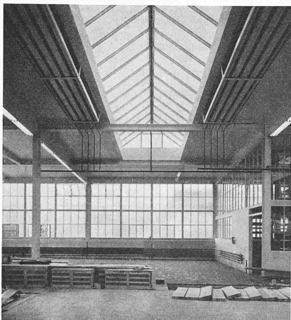
Bild 1. Werkhalle mit Hochtemperatur-Strahlungsheizung in Form von Bandstrahlern
