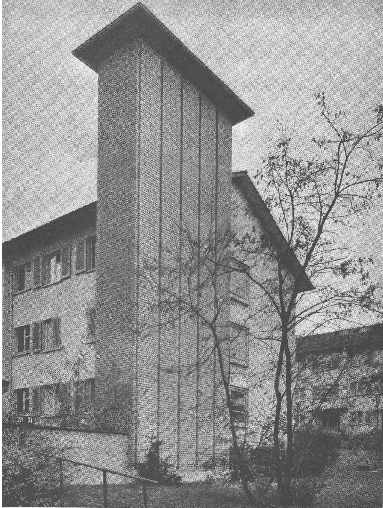
5-Züger Kamin einer Heiz- und Warmwasserzentrale
