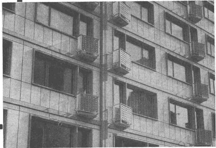
Ausfachung eines Beton-Skelettbaues
