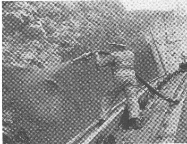
Felskonsolidierung bei der Druckleitung des Kraftwerkes Mauvoisin
