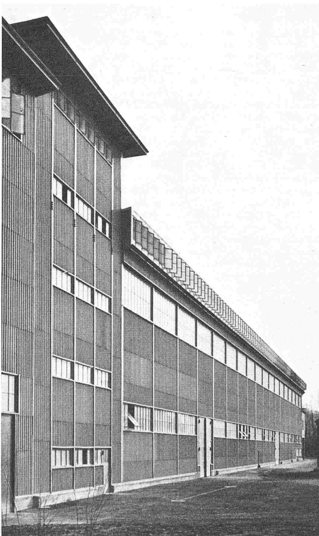
Bild 4. Ansicht der Nordfassade aus Osten
