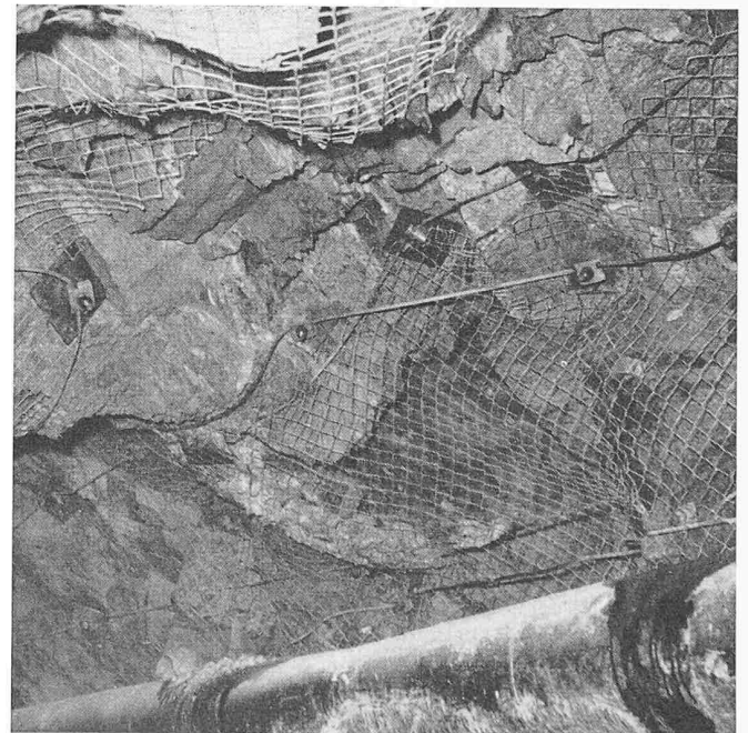
Bild 10 (links). Felsanker-Ring zur Sicherung der Firste
