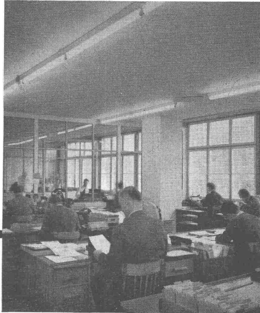
Klimaanlage «System Häusler» in Bürogebäude
