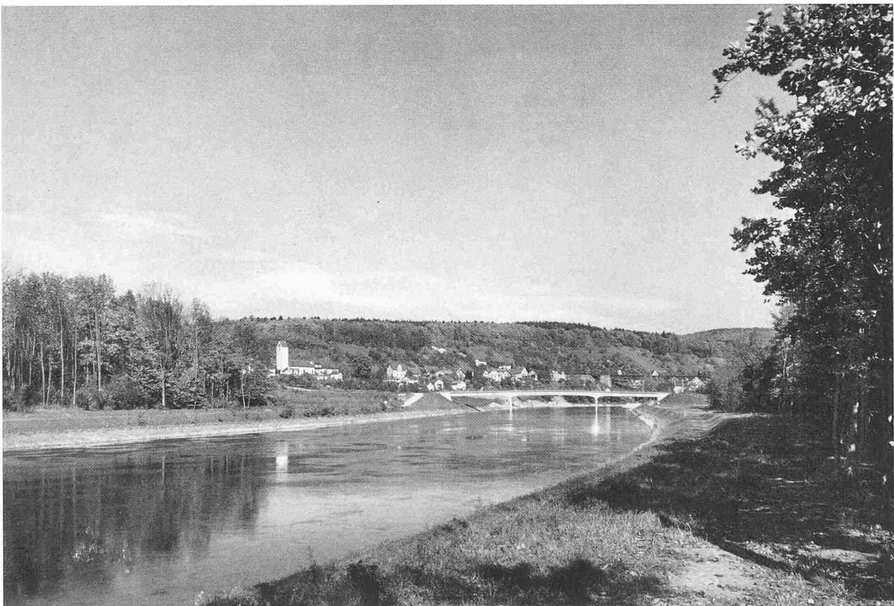
Bild 31. Unterwasserkanal bei Umiken, 19. Oktober 1954
