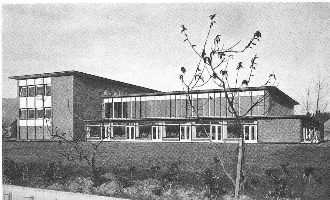
Haupteingangs-Seite, Ansicht aus Südwesten. Links Personal-Anbau
