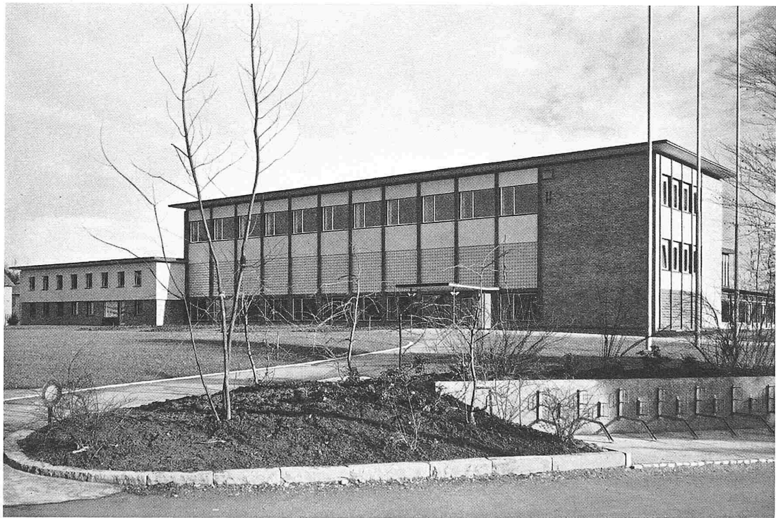
Ansicht aus Südosten
