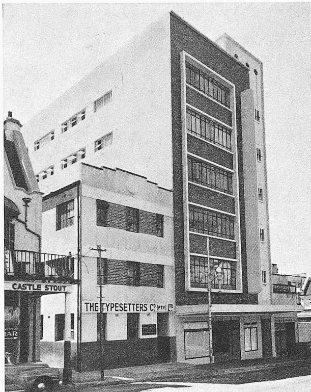
Geschäftshaus Rhodone in Cape Town; Eisenbetonskelettbau, zwei-stielige Rahmen
