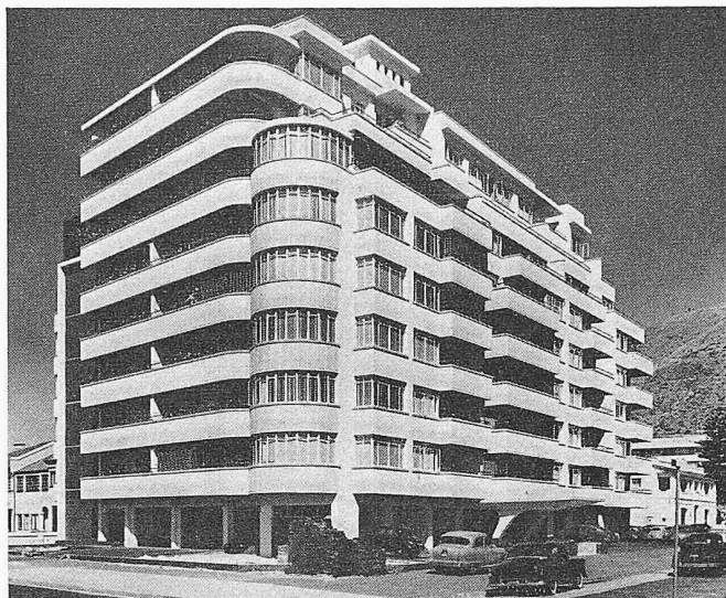
Apartmenthaus «Beach Court» Ltd. in Cape Town, Eisenbeton-Skelettbau mit 72 Wohnungen. Vordach über dem Haupteingang
