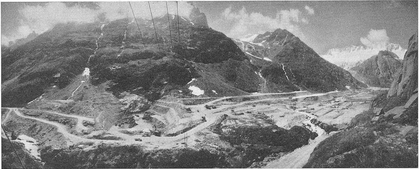
Bild 4. Sperrstelle und Staugebiet. Im Vordergrund der Aushub im Bereiche der Dammxase, damit der Dichtungskern auf den Fels abgestellt werden kann. Das Aushubmaterial, das für den Dammbau wieder zur Verwendung kommt, wird im zukünftigen Staugebiet auf Zwischen-deponie gelegt. Im Hintergrund rechts ist ein Teil des Fangdammes zu erkennen.
