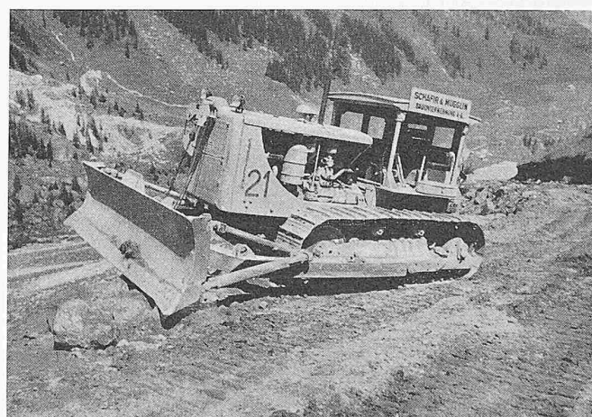
Bild 2. Bulldozer Caterpillar D 8, Gewicht 22 t, Motorenleistung 190 PS
