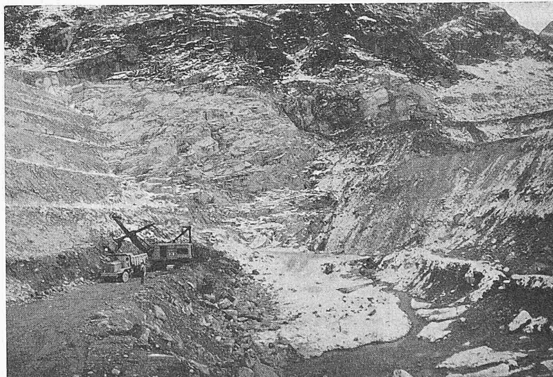
Bild 12. Baugrube für den Dammkern; Stand der Aushubarbeiten Ende Oktober 1956
