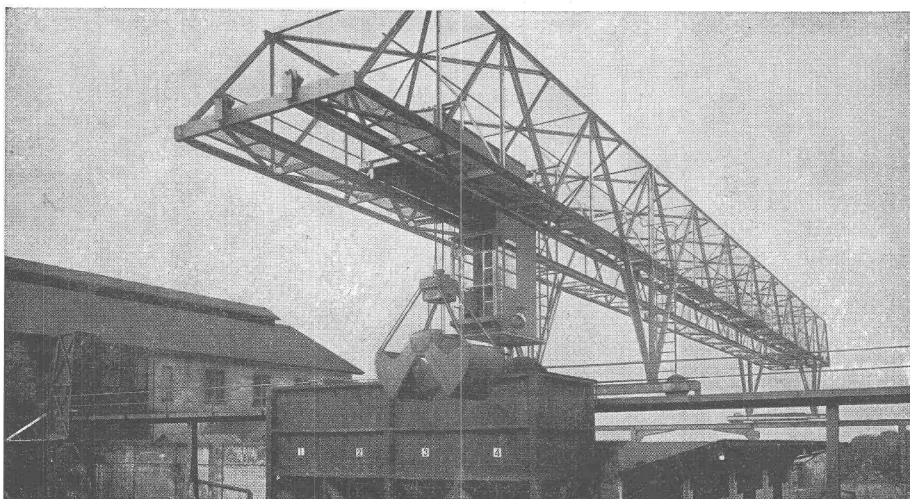
Verladebrücke in Schweisskonstruktion 2,5 t Tragkraft, 46 m Länge
