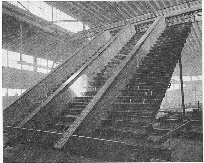
Bild 26. Orthotrope Platte in der Werkstätte, gesehen von unten (Die hellen Stücke sind die Holzgriffe der Kupferschienen für die Schweißung). Grösse des Stückes 5 \times 8 m. Nach dem Umdrehen werden zwei solche Stücke vor dem Transport auf die Baustelle zu einer Tafel von 5 \times 16 m zusammengeschweisst
