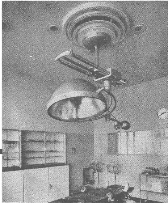
Klimaanlage «System Häusler» in Operationssaal eines Spitals
