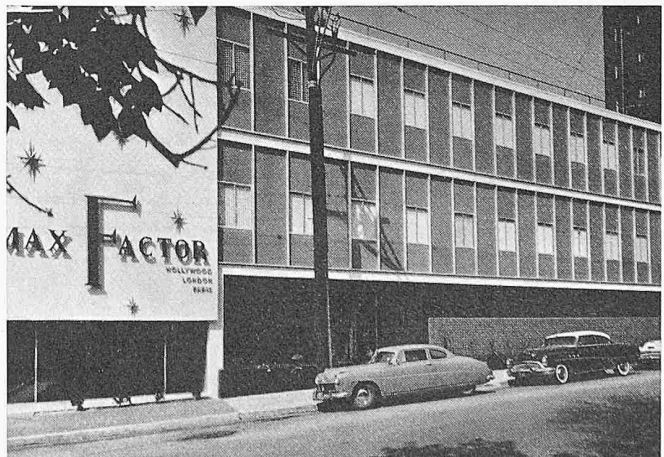
Fig. 9. Immeuble de bureaux Max Factor
