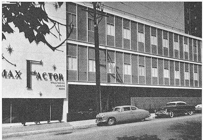
Fig. 9. Immeuble de bureaux Max Factor
