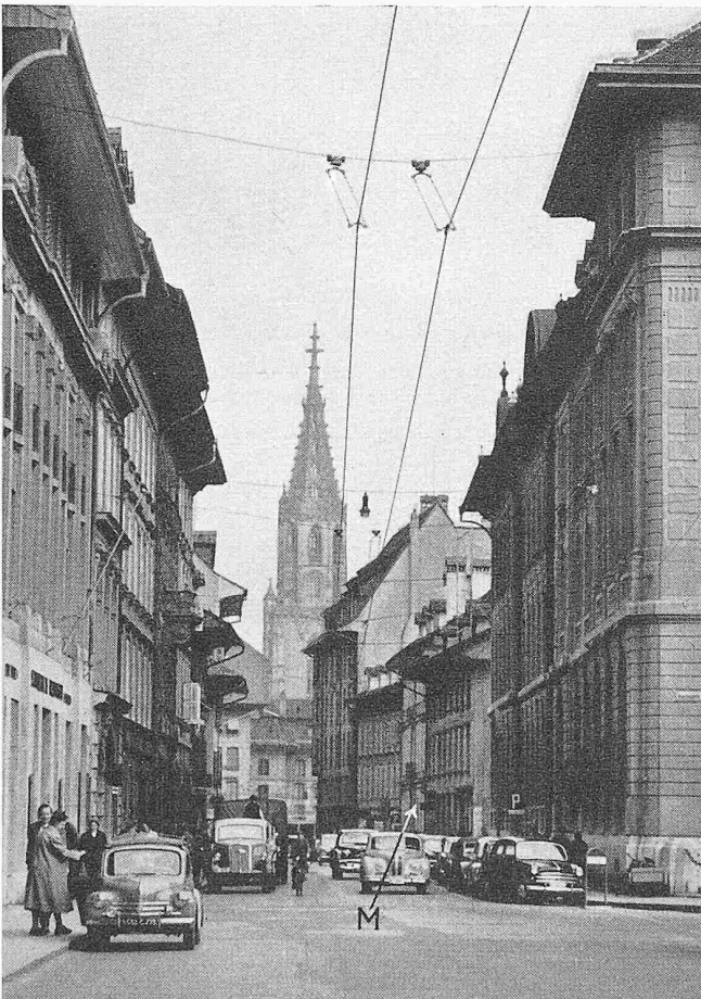
Bild 1. Blick vom Bundesplatz in die Amtshausgasse, M = Marcuardhaus
