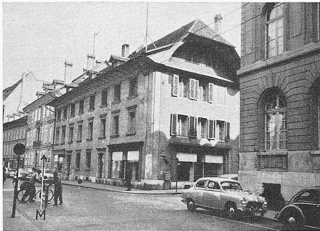
Bild 3 (rechts). Das Abbruchobjekt, an dessen Stelle der Neubau treten soll
