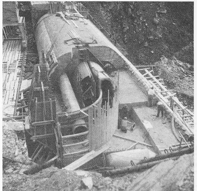
Bild 11. Steinwasserfassung im Bau (10. Sept. 1954), Blick gegen die linke Talseite
