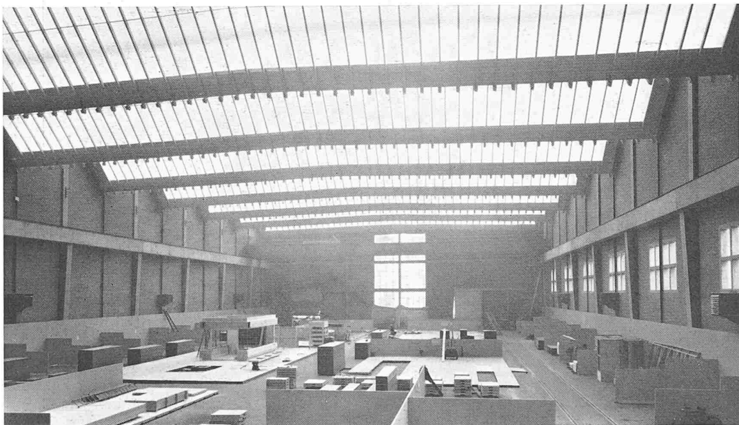
Innenansicht in Richtung Nord. Beginn des Aufbaues der Einrichtungen für die Mustermesse 1958
