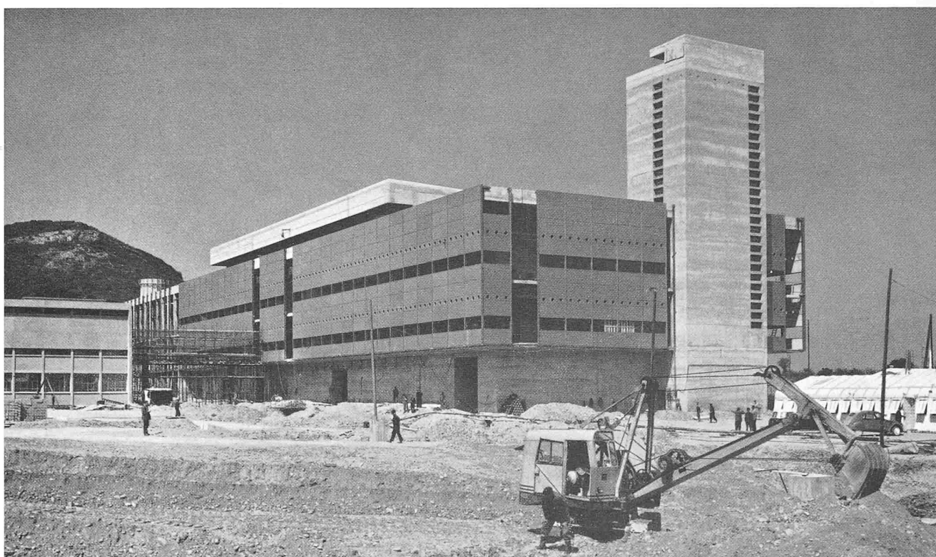
Bild 15. Das Gebäude der Plutonium-Gewinnungsanlage im Bau.
