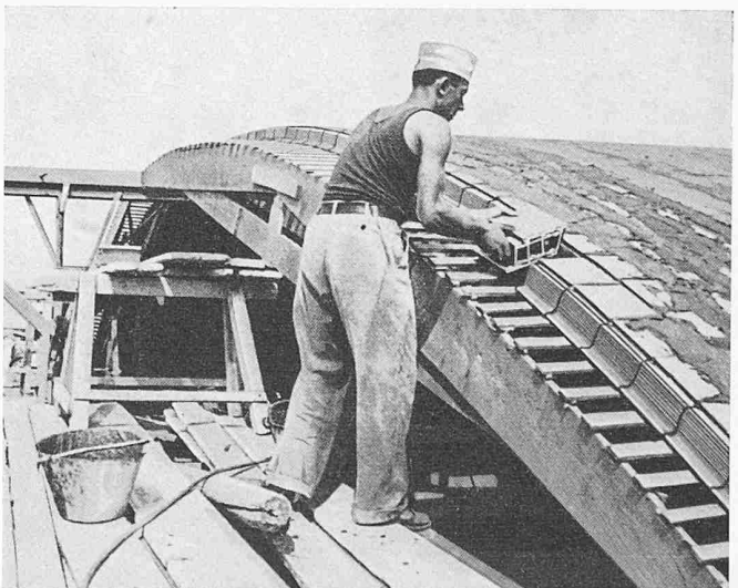
Bild 15. Ausführung der Schale mit einer beweglichen Lehre
