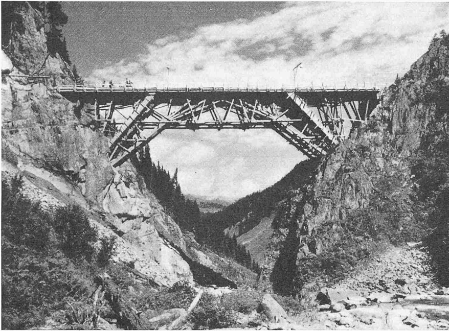
Bild 13. Lehrgerüst Val Nalps, im Freivorbau erstellt
