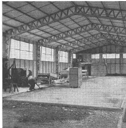
Die neue Fabrikhalle der Int. Verbandstoff-Fabrik Neuhausen a. Rheinfell
