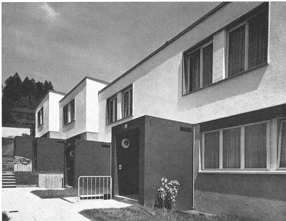
Eingangspartie der 2. Etappe aus Süden
