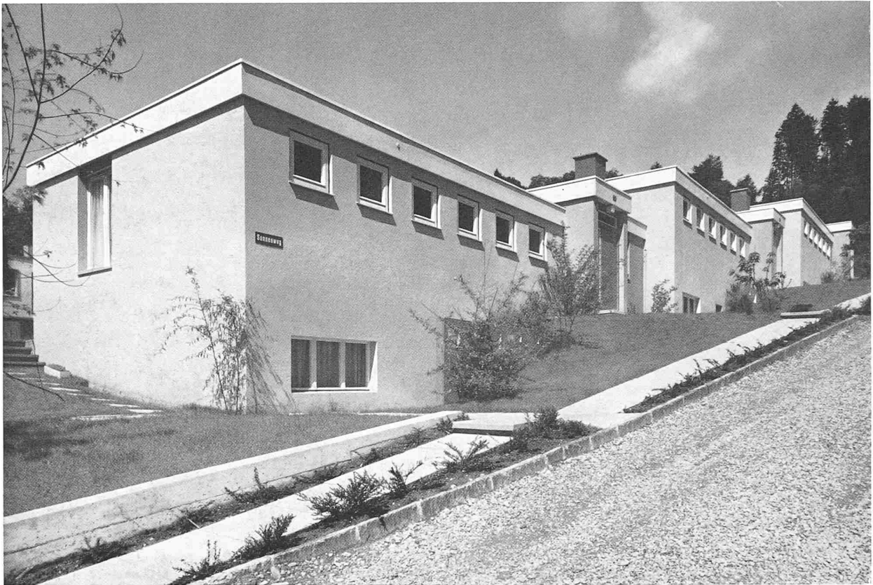
Rückfront der 1. Etappe aus Osten
