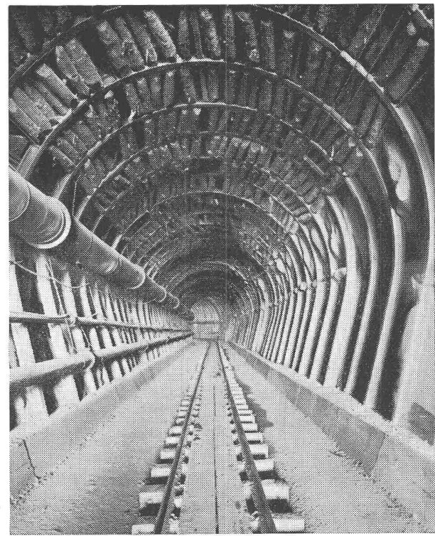
Stollen mit Stahleinbau in gebrächem Fels
